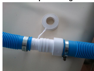
namestitev prehodnega kosa 32/32/38/38mm
